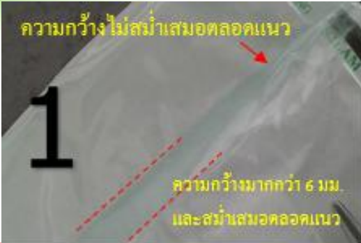
รอยซิลล์กว้างไม่สม่ำเสมอตลอดแนว (มากกว่า 6 ม.ม.)
